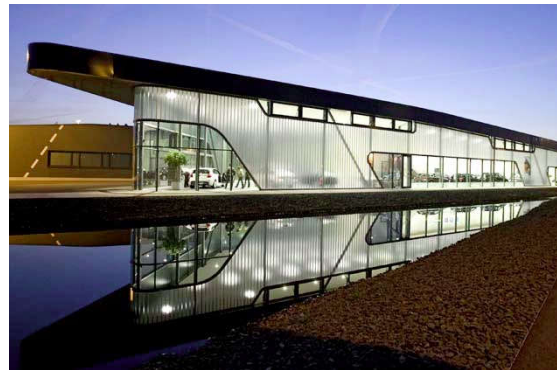
Toàn cảnh showroom trong toà nhà trung tâm hãng ô tô BMW tại Leipzig - công trình với vật liệu cơ bản là bê tông xuyên sáng
